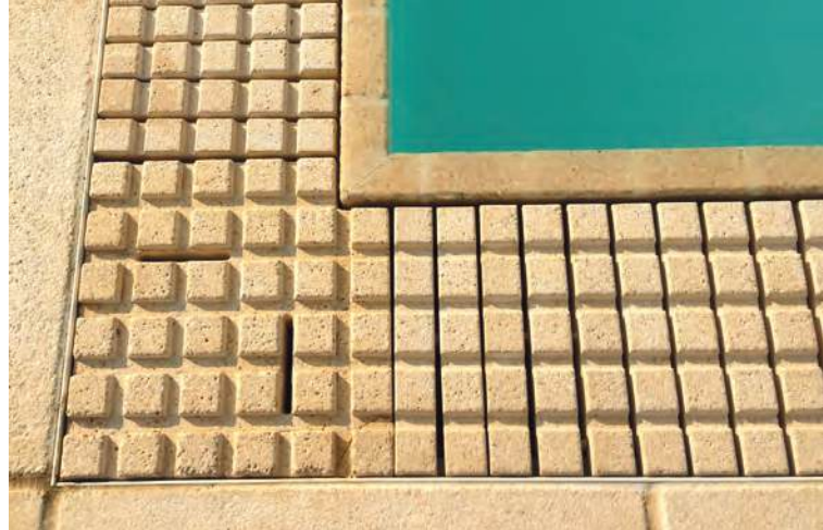
Piscina Sfiro-Top Evolution Particolare angolo griglia tassellata
